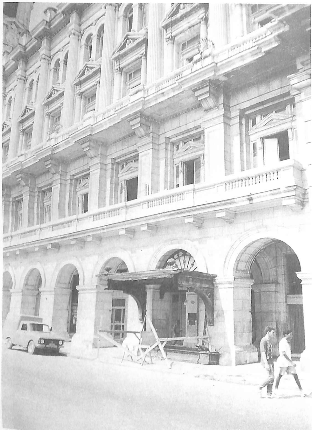
Fachada lateral del Antiguo Centro Asturiano de La Habana. Entrada de acceso a la Taberna (estado actual)
